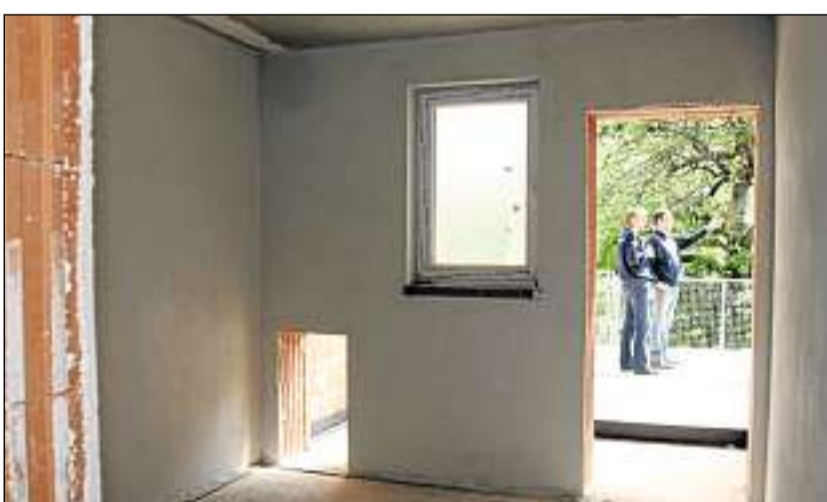
Jedes Hundezimmer bekommt eine Klappe, die Freigang ermöglicht.
