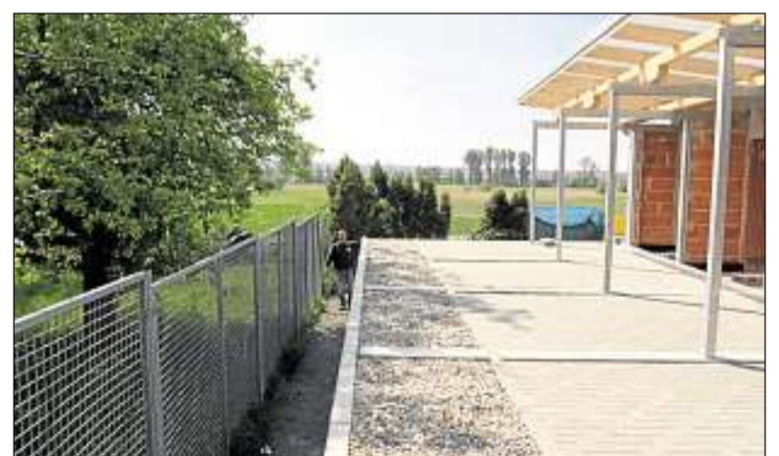
Mannshoch ist das neue Fundament gebaut, wie Robert Neureuther beweist.
