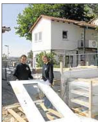
35 Glastüren wurden eingebaut.
